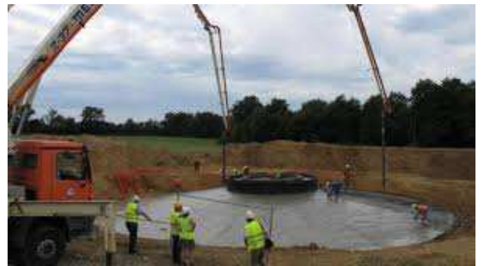
Nouvelle République le 05/07/2014 : coulage d'un socle d'éolienne à Adriers
